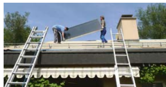
Gebäudehüllensanierung als Chance genutzt. Sonnenkollektoren dienen der Warmwasseraufbereitung.
