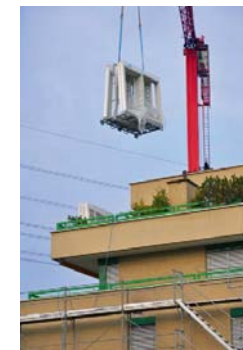
Mittels mobilem Kran werden die Schallschutzfenster auf den Attikageschossen angeliefert.
