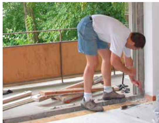
Demontage der sanierungsbedürftigen Fenster
