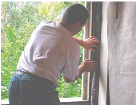
Vorbereitungen für den Einbau: Isolation der Hohlräume
