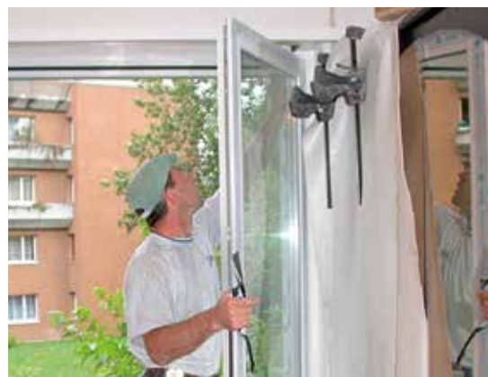
... und schliesslich werden die Fensterflügel eingesetzt
