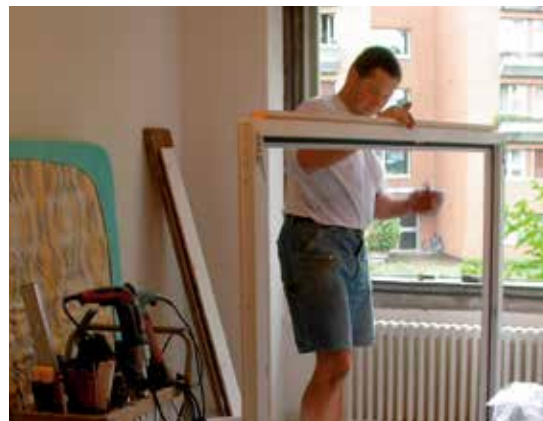
Die neuen Fensterrahmen werden eingesetzt...
