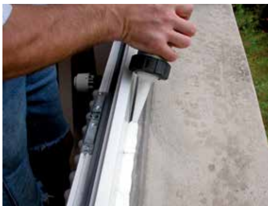
...montiert und abgedichtet...
